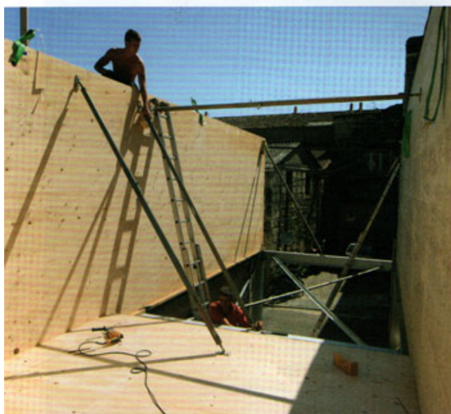
Mise en place de la partie agence.
